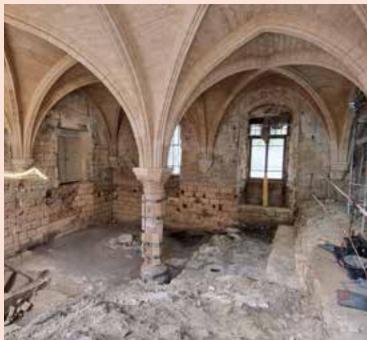
© SDAO. Vue générale de la fouille au château royal de Creil
