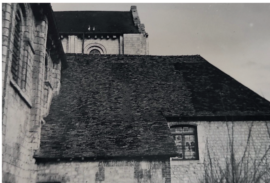
83. Photographie de la couverture Ouest de la sacristie , sans date. Médiathèque du patrimoine et de la photographie.
