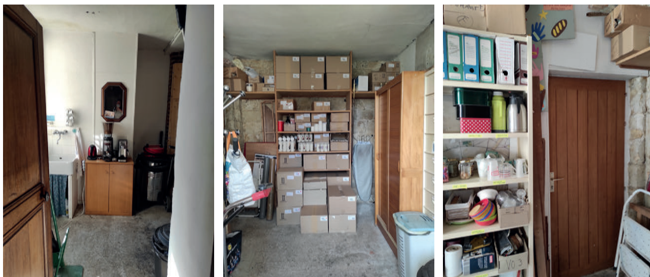
107. à 109. Volume de stockage de la sacristie et porte d'accès menant au jardin privé accolé à l'édifice.
