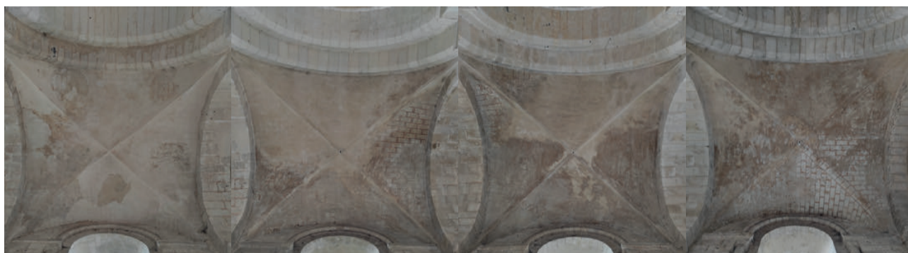
101. Voûtes d'arêtes du bas-côté Nord de la nef (quatre dernières travées).
