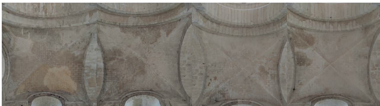
100. Voûtes d'arêtes du bas-côté Nord de la nef (quatre premières travées).
