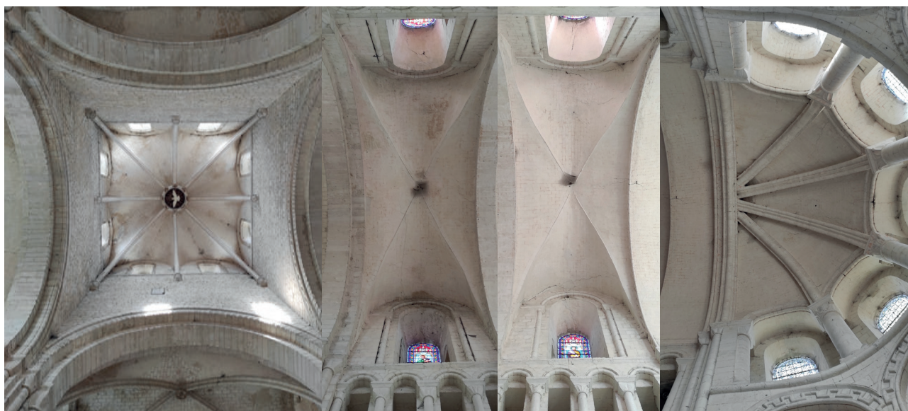
93. Voûtes de la croisée au droit de la lanterne et celles du chœur.
