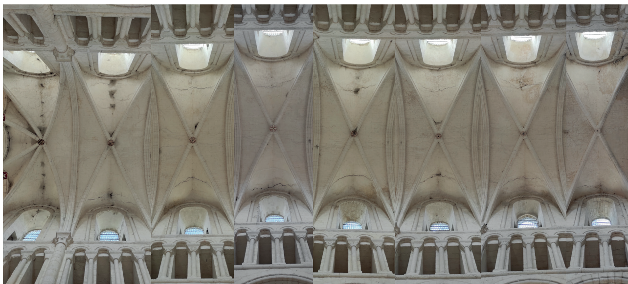
91. Voûtes sur croisées d'ogives du vaisseau principal de la nef, de l'Ouest vers l'Est.
