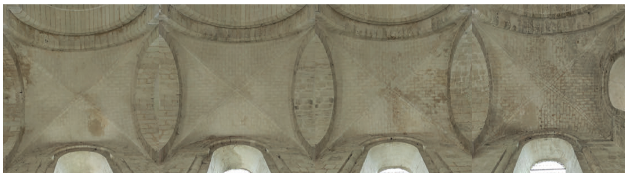
103. Voûtes d'arêtes du bas-côté Sud de la nef (quatre dernières travées).
