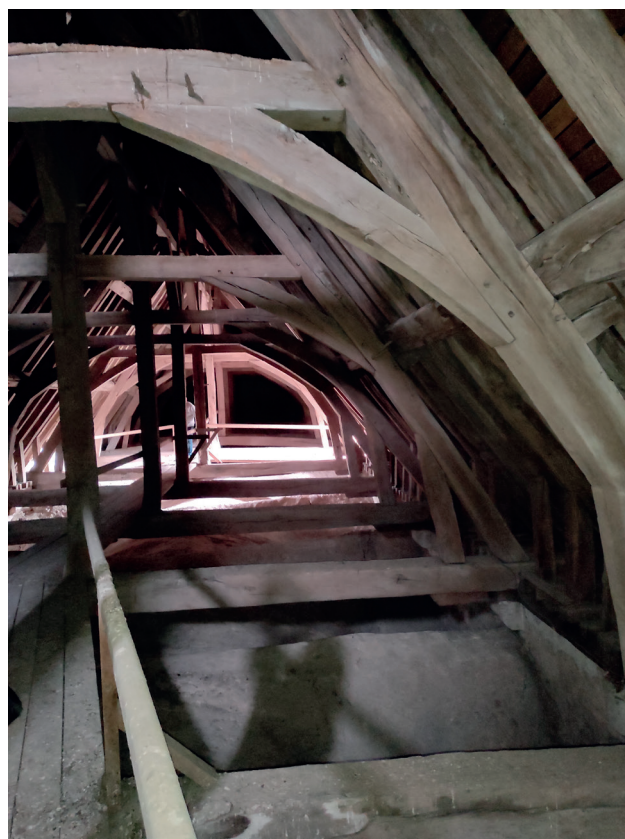
115. à 116. Comble du vaisseau principal de la nef avec chevrons porteurs et fermes principales portant pannes.
