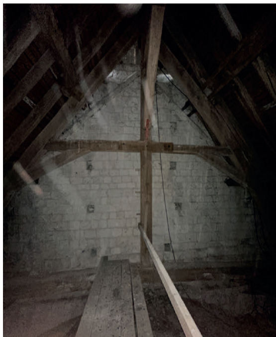
117. Dernière ferme accolée au mur du clocher.
