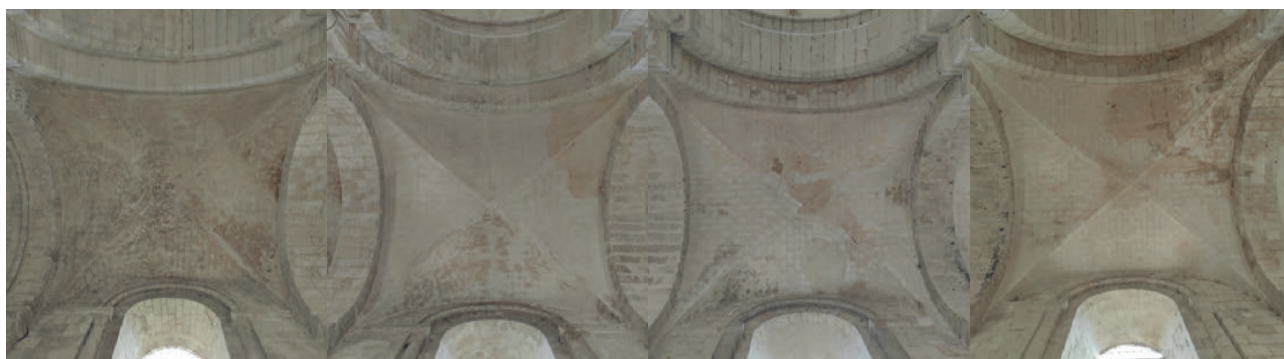
102. Voûtes d'arêtes du bas-côté Sud de la nef (quatre premières travées).
