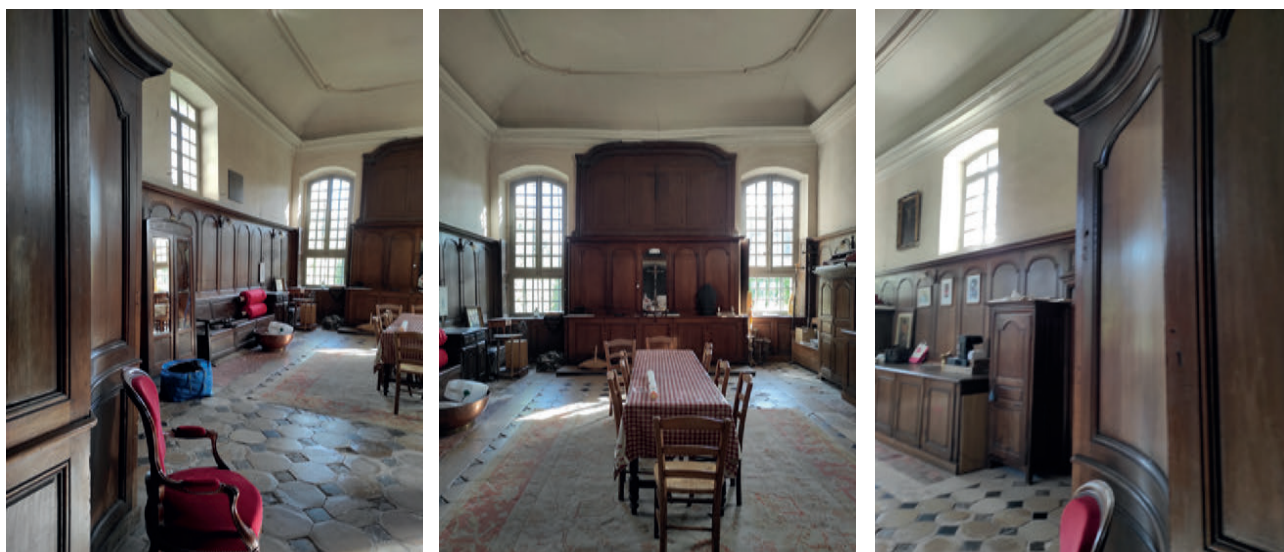
104. à 106. Intérieur de la sacristie, lambris et mobiliers en bois, sol avec dallage à cabochons.
