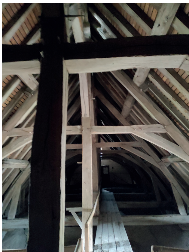
115. à 116. Comble du vaisseau principal de la nef avec chevrons porteurs et fermes principales portant pannes.
