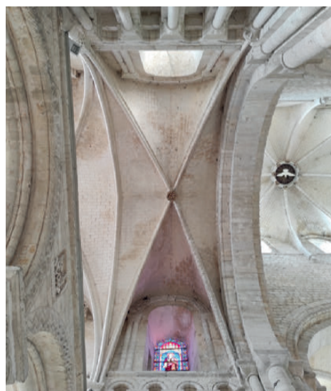
98. Voûtes du croisillon Sud.
