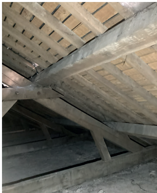
118. Comble du bas-côté de la nef (Sud).
