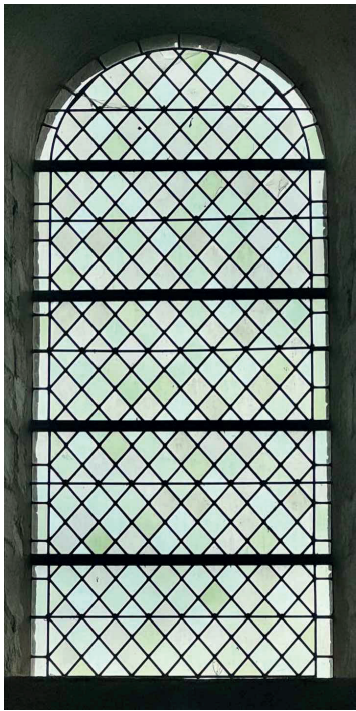
NEF : BAIES 21 à 32 ; 34 et 36 Vitrerie losangée
