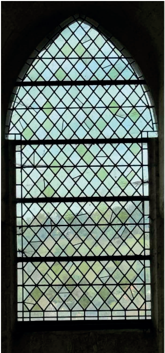
NEF : BAIE 123 Vitrerie losangée
