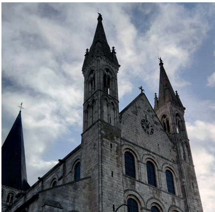
3. Encrassement épidermique des parements du volume occidental.
