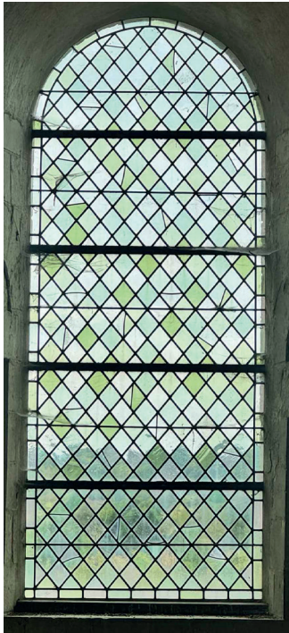
TRANSEPT : BAIES 117 et 119 Vitrerie losangée.
