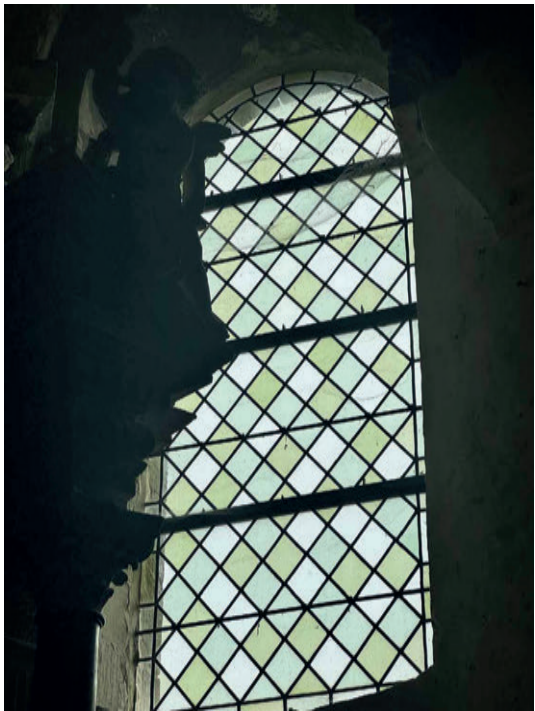
TRANSEPT : BAIES 12 ; 14 ; 19 et 20 Vitrerie losangée
