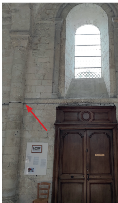
28. Première travée du bas-côté Sud, 29. Câble d'alimentation non coulé de condensation en dessous de la baie, absence de système de récupération des eaux, fissure dans la maçonnerie. 30. Rejointoiement grossier.
