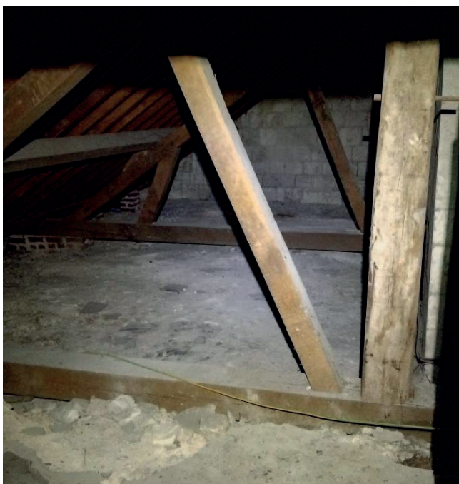
7. Remblaiement de la voûte par une chape en plâtre (extrémité bas-côté Nord du chœur).
