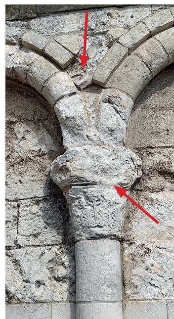
12. Pierres érodées et perte de matière au droit des arcades aveugles. Perte de la nervosité dans la taille des ornements.
