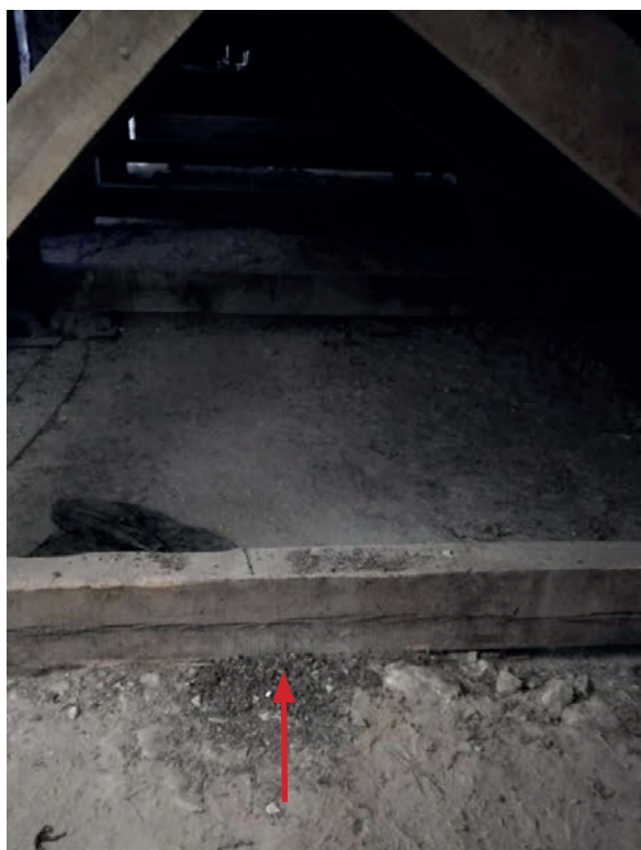
3. Léger appui de l'entrait sur l'arc (bas-côté Sud de la nef).
