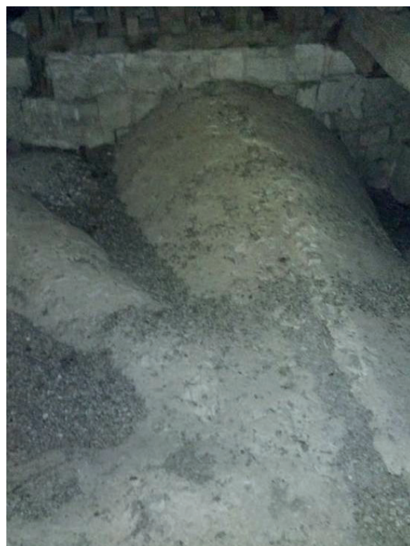
4. Extrados des voûtes sur croisée d'ogives en moellons remblayés au niveau des tas de charge (bas-côté Sud de la nef).
