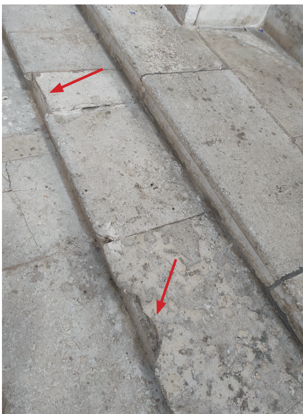
55. Perte de matière au droit de l'embranchement. Nez de marche abîmé ou manquant.
