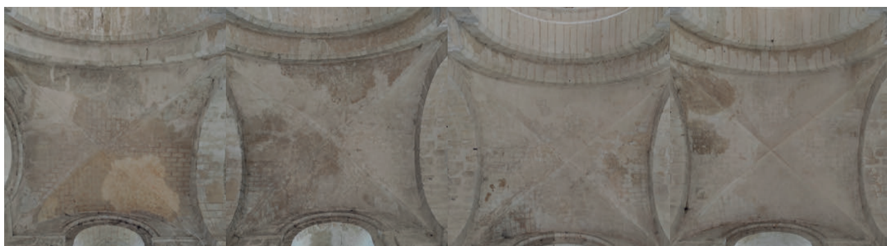
12. Voûtes du vaisseau principal de la nef, fissures dites de Sabouret traduisant un déliaisonnement continu avec les gouttereaux, réseau de micro-fissures.
