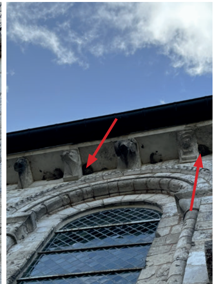
5. Colonisation de volatiles prenant pied d'élévation, développements de mousses et de micro-végétaux, érosion des pierres et perte de matière.
