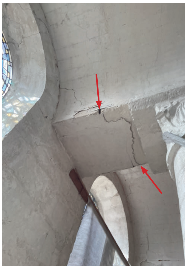
23. à 27. Fissures au droit des voûtains du revers de la façade Ouest ainsi qu'en allèges de baie.
