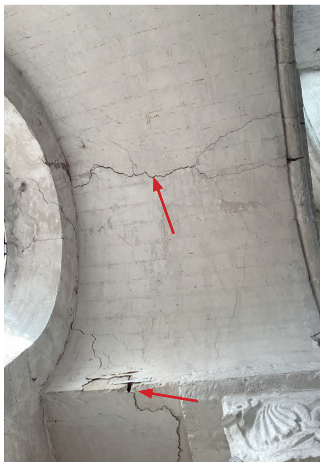
23. à 27. Fissures au droit des voûtains du revers de la façade Ouest ainsi qu'en allèges de baie.
