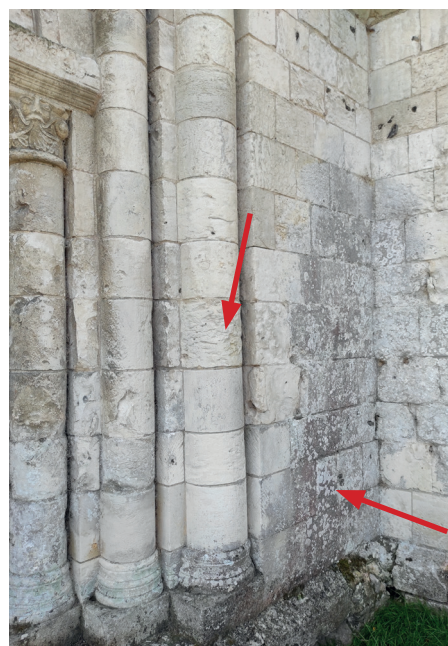
9. Pierres érodées, perte d'épiderme et grande présence d'humidité.
