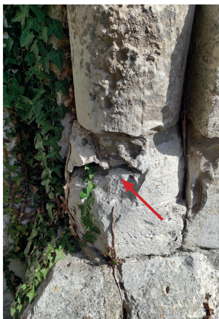
7. Perte importante de matière entraînant une illisibilité des modénatures taillées.
