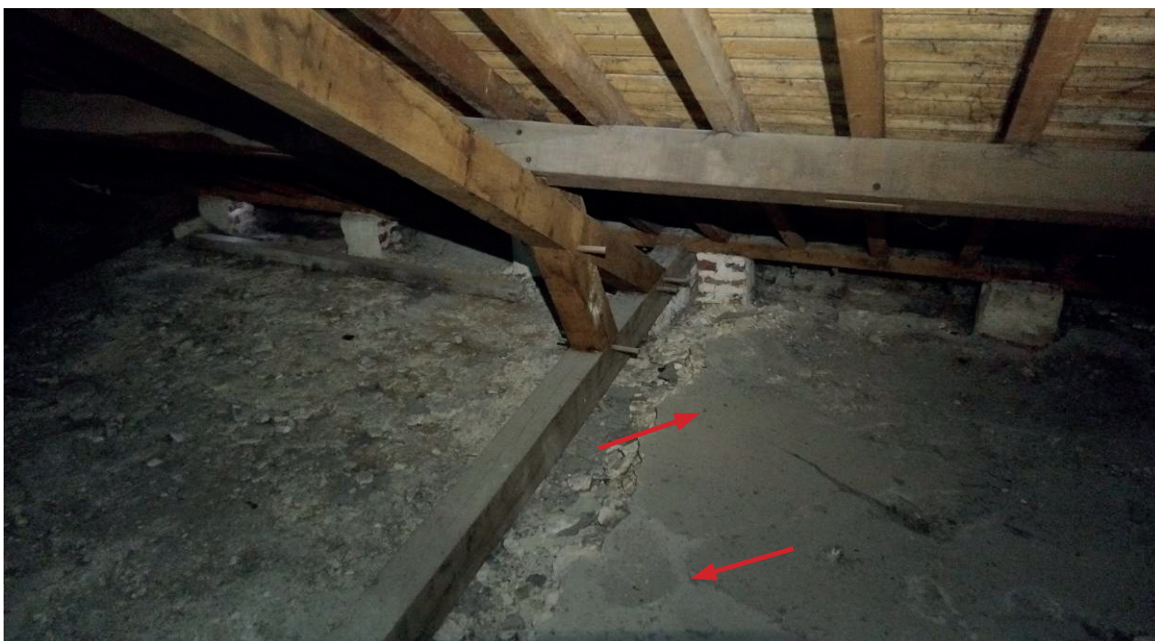
6. Mise en œuvre d'une chape en plâtre de 20cm à la clé sur les voûtes des chapelles orientées, traces d'efflorescences salines (bas-côté Sud de la nef).
