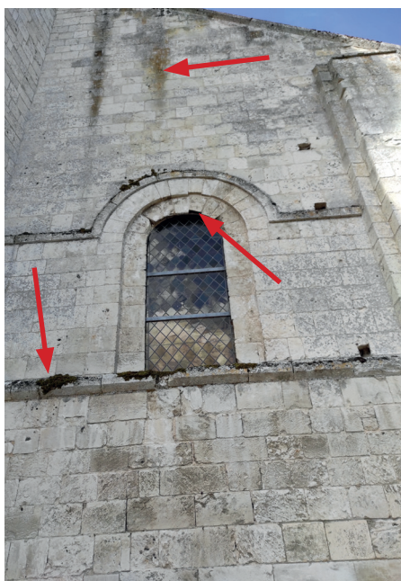
5. Bandeau fortement colonisé par les mousses et micro-végétaux. Encadrure de baie présentant des pierres désorganisées et cassées, coulures d'eau de pluie
