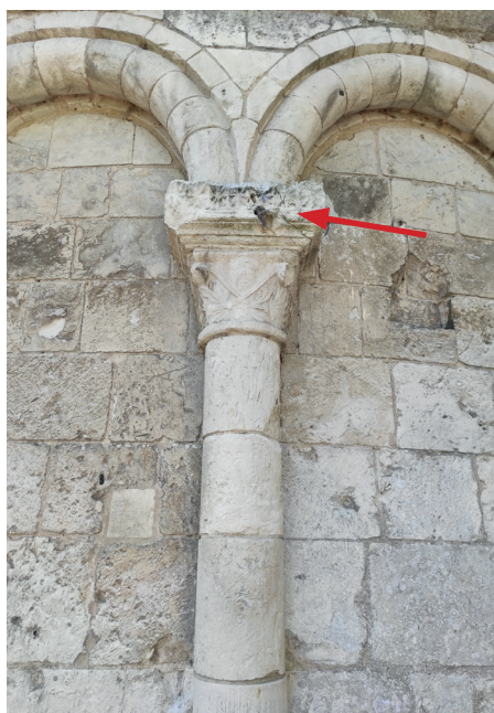
8. Pierres érodées, perte de la nervosité des sculptures des chapiteaux.
