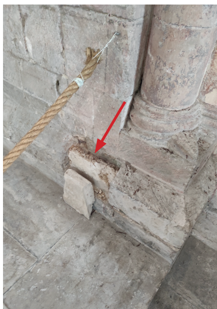
36. Perte de parement en pied de colonne.
