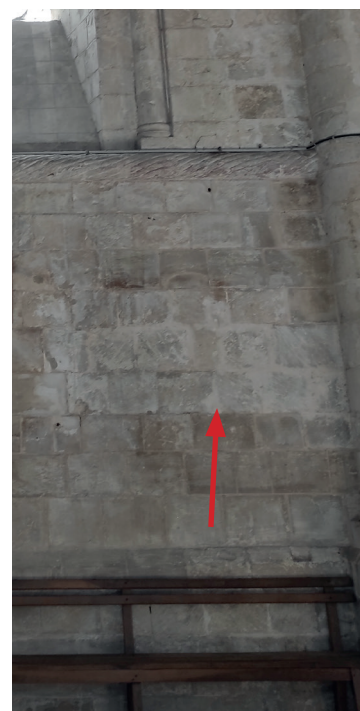
28. Première travée du bas-côté Sud, 29. Câble d'alimentation non coulé de condensation en dessous de la baie, absence de système de récupération des eaux, fissure dans la maçonnerie. 30. Rejointoiement grossier.
