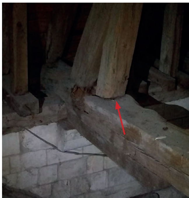
10. About d'entrait de charpente altéré, assemblage de jambe de force ouvert (vaisseau principal de la nef).
