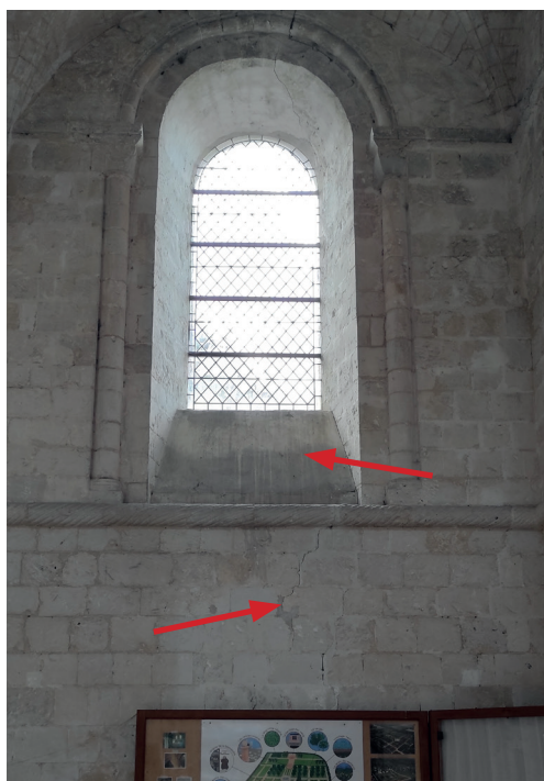
28. Première travée du bas-côté Sud, 29. Câble d'alimentation non coulé de condensation en dessous de la baie, absence de système de récupération des eaux, fissure dans la maçonnerie. 30. Rejointoiement grossier.
