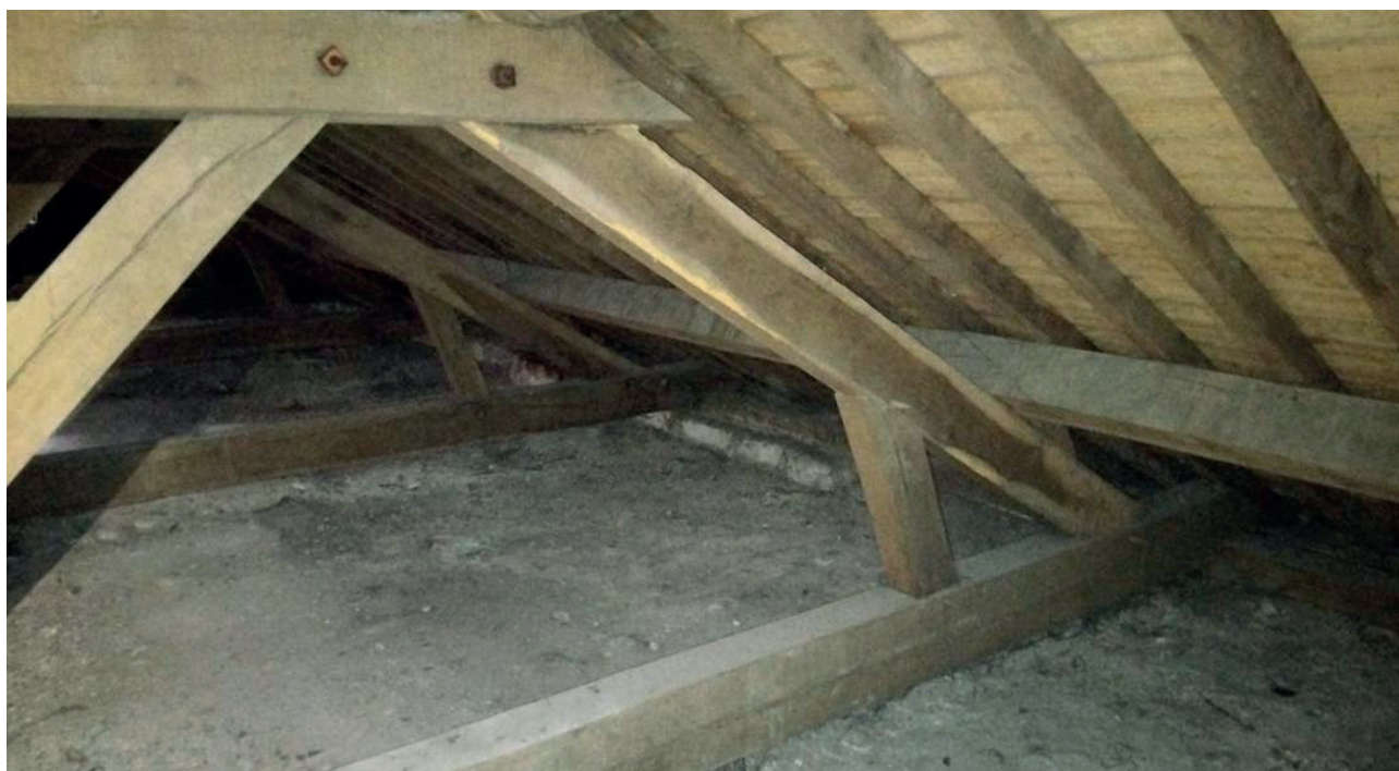
5. État correct des charpentes (bas-côté Sud de la nef)..
