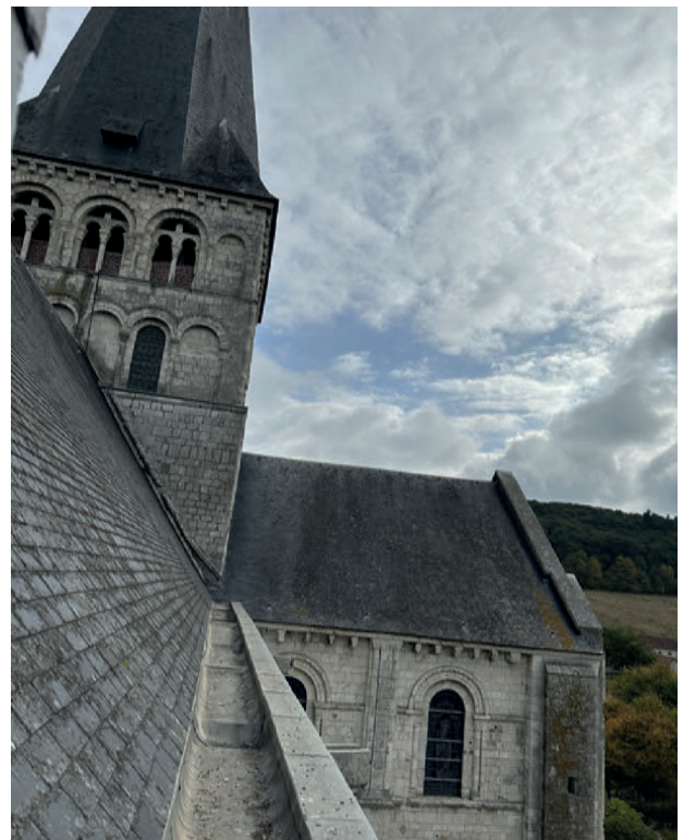
5. Couvertures du bras Sud du transept depuis le chéneau du vaisseau principal de la nef, et beffroi du clocher.
