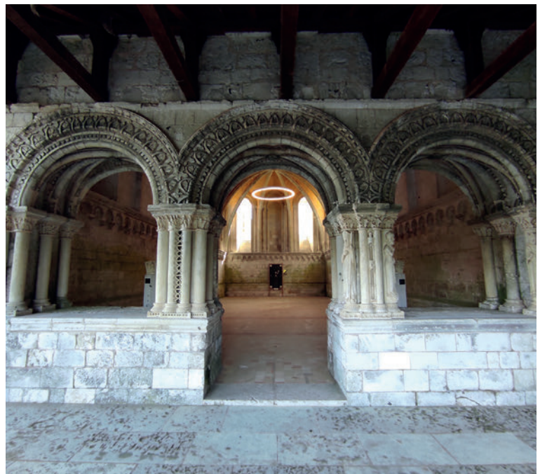
11. Partie inférieure de la salle capitulaire abritée sous la galerie. Détail des arcades richement sculptées: salle capitulaire, hors champs d'étude.
