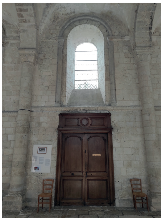
7. Revers Sud, sixième travée, porte d'accès à la sacristie.
