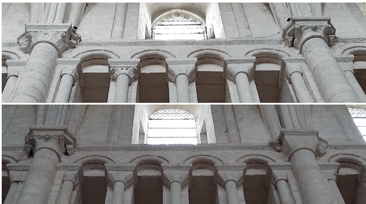
40. Détail des chapiteaux du triforium, septième travée (dans l'ordre de lecture Nord puis Sud).
