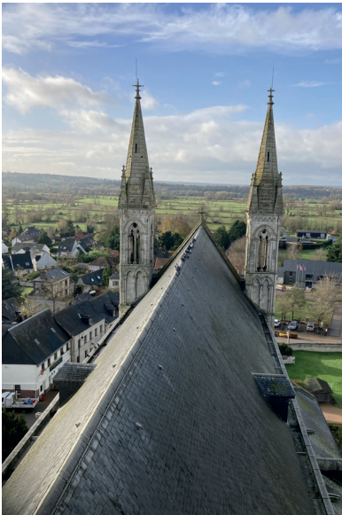
1. Couverture du vaisseau principal de la nef et tourelles du massif occidental.
