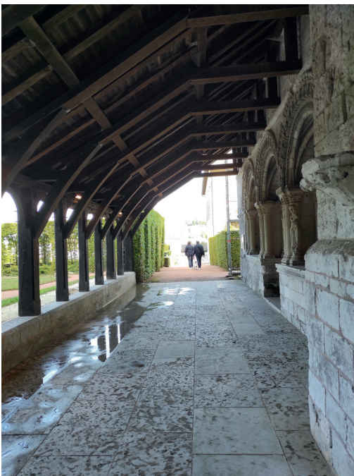
10. Détail de la galerie dont la toiture en appentis prend appui sur la salle capitulaire depuis la sortie de secours de l'église.
