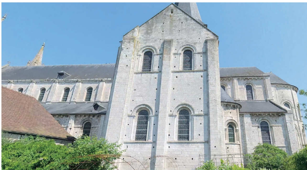
4. Vue générale de l'élévation Sud de l'église au sein du jardin de l'abbaye.
