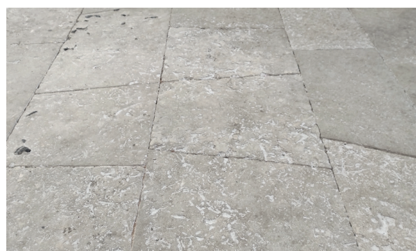
15. Détail du revêtement du sol dans le vaisseau principal.
