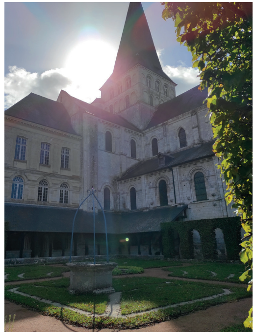
9. Vue sur le clocher et la salle capitulaire accolée au bras Nord du transept depuis le cloître.
