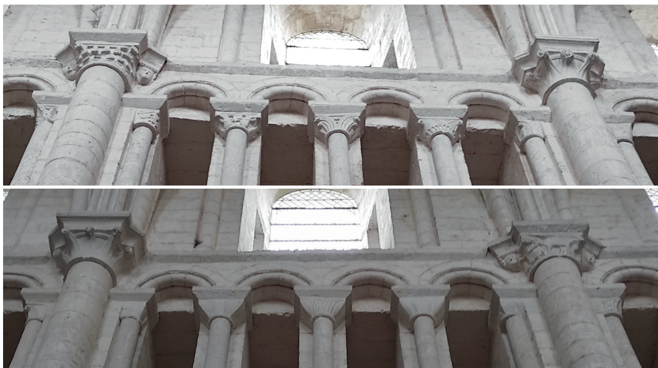
38. Détail des chapiteaux du triform, cinquième travée (dans l'ordre de lecture Nord puis Sud).
