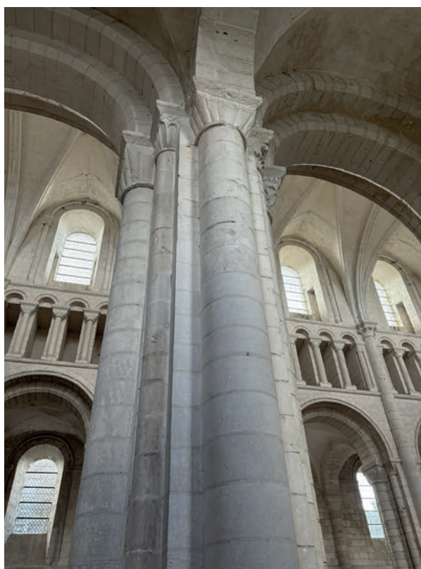
13. Détail des colonnes qui séparent le vaisseau principal de ses bas-côtés; grandes arcades, triforium et baies hautes.
