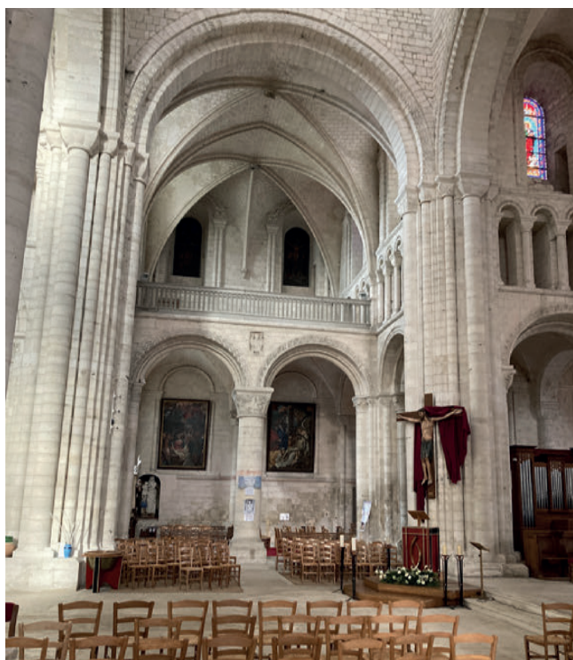
16. Vue générale du bras Nord du transept depuis le bras Sud. Tribune en partie supérieure de la travée d'extrémité.
