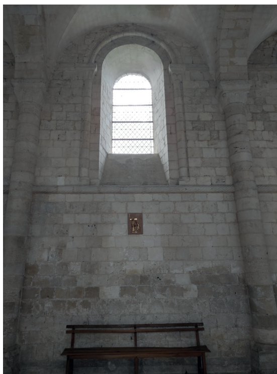
6. Traitement des bas-côtés : baie en partie supérieure, appareillage soigné quasi régulier.
