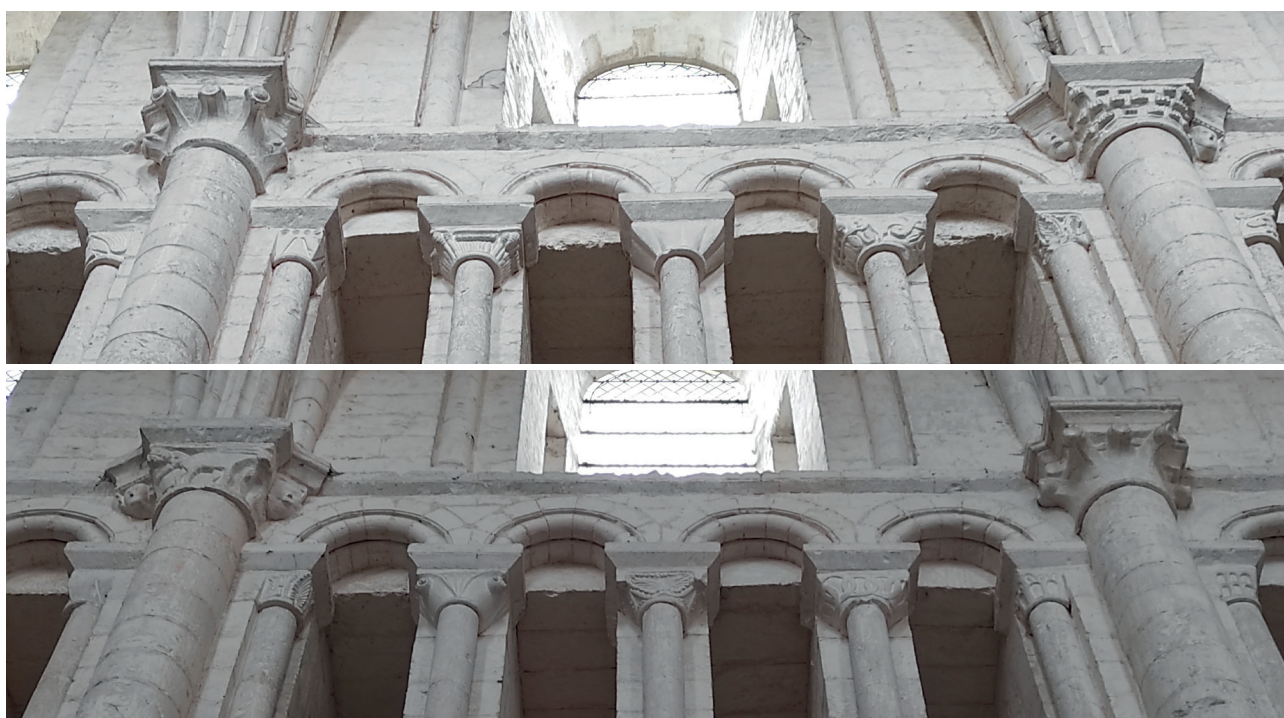
37. Détail des chapiteaux du triforium, quatrième travée (dans l'ordre de lecture Nord puis Sud).
