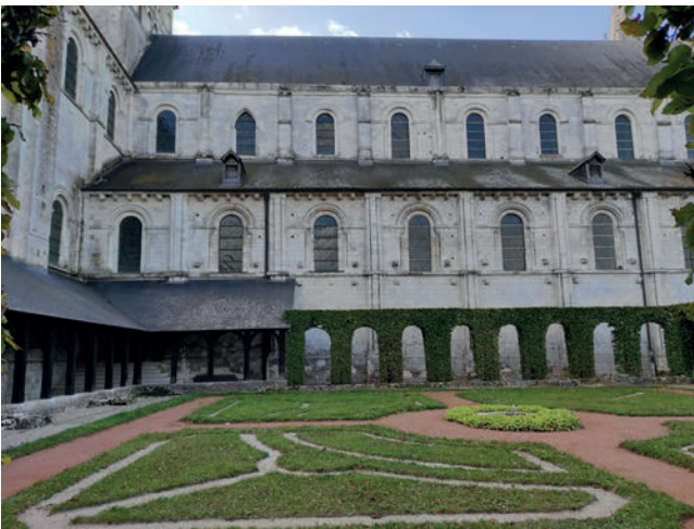
2. Élévation de la nef se développant sur deux niveaux distincts, laissant lire le gouttereau du bas-côté et celui du vaisseau principal.
