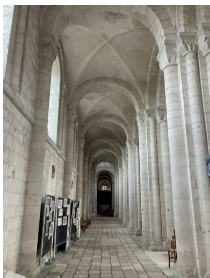
10. Bas-côté Nord, en direction de la chapelle à l'Est.
