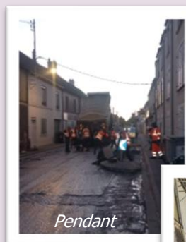
Rénovation tapis enrobés de la RD319 par le Conseil Départemental de Seine-et-Marne
