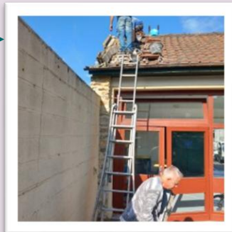
Réparation de la toiture du préau de l'école élémentaire
