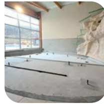
DÉBUT DES TRAVAUX du jardin d'eau au Centre Aqualudique Nautilou
