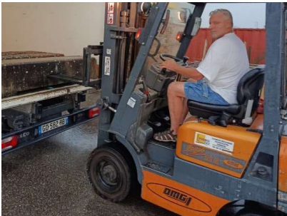
Chargement des blocs de béton : le Fenwick entre en scène.
