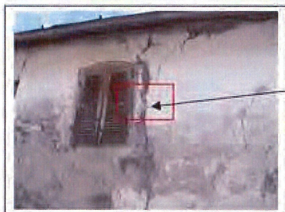
Fissures sur les murs d'une maison au hameau de Chaucisse – Les Témoins mis en place en avril 1983 atteste que le glissement est toujours actif. Source : MB Management, novembre 2009
