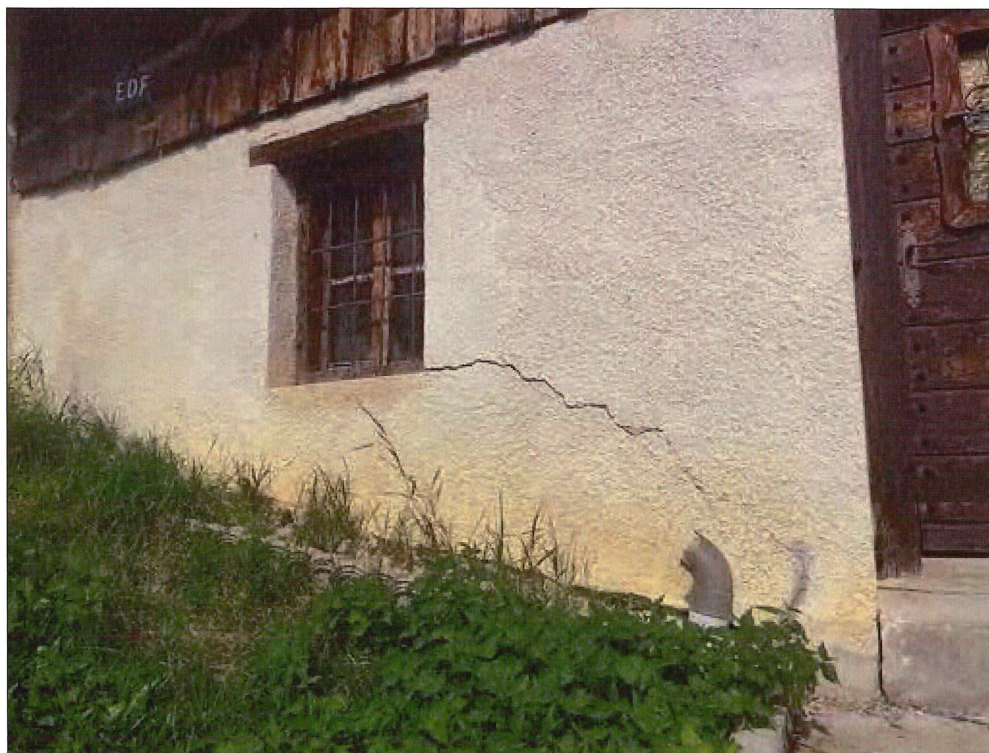
Figure III.5: Fissuration du mur Ouest du chalet en parcelle 1113
