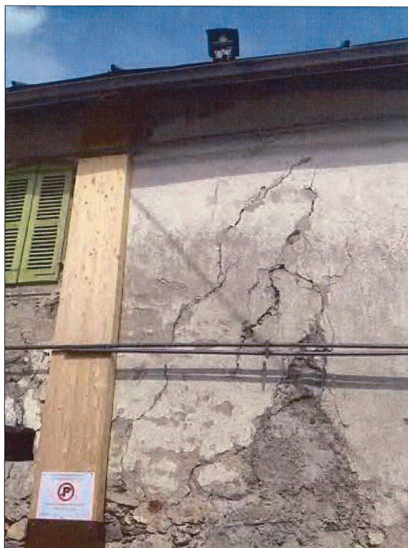
Figure III.8: Multiples fissures sur le mur ouest de la Cure
