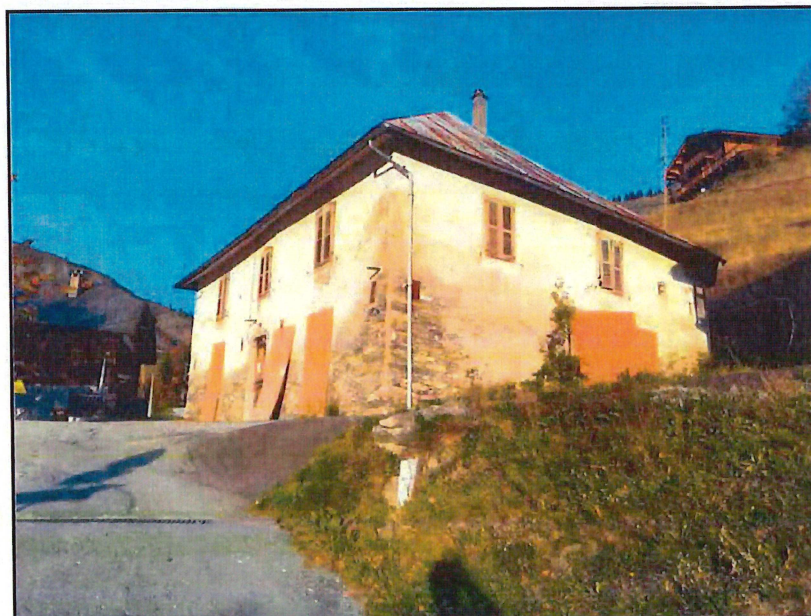
Figure 1 : Photographie du site
