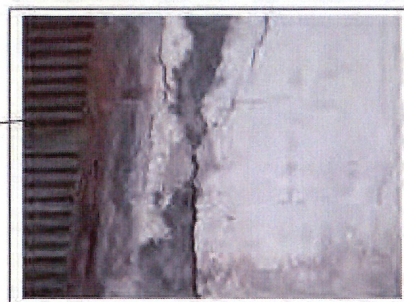
Fissures sur les murs d'une maison au hameau de Chaucisse – Les Témoins mis en place en avril 1983 atteste que le glissement est toujours actif. Source : MB Management, novembre 2009
