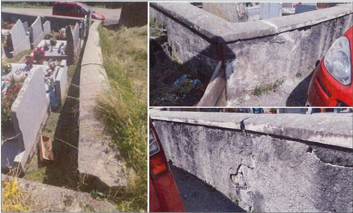
Figure III.2: Fissurations sur le mur d'enceinte du cimetière de Chaucisse
