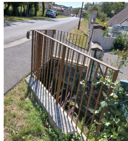
Sécurisation du ru chemin du bois brûlé
