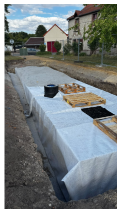
Installation bac tampon rue de Verdun
