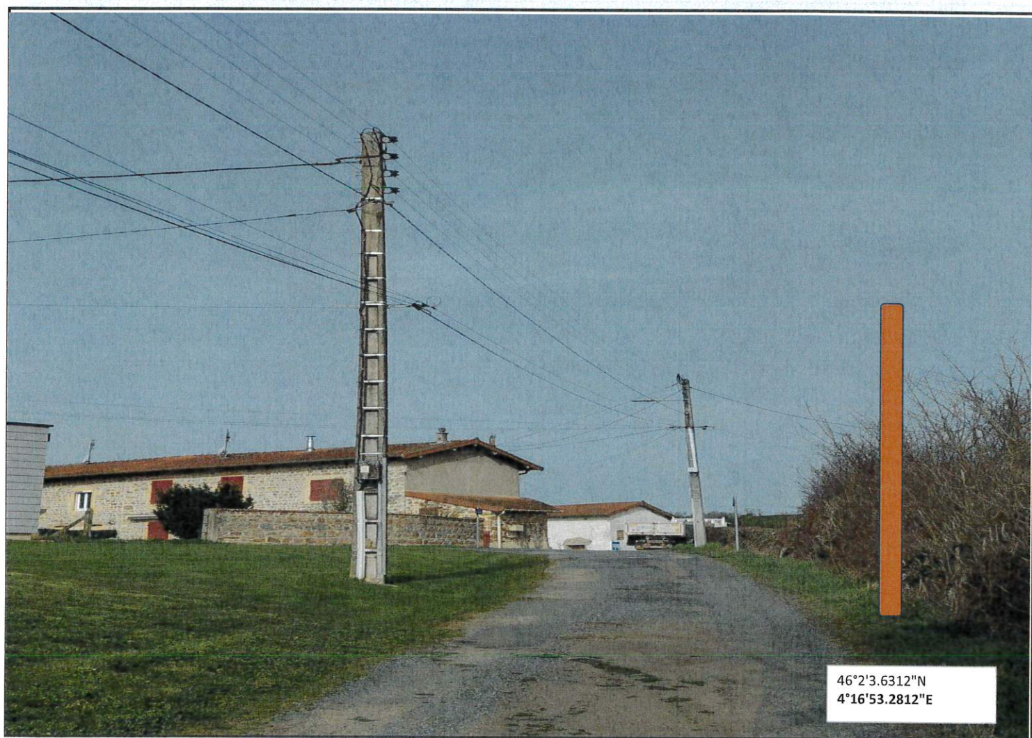
PHOTO DE L'APPUI 2032070 AVANT TRAVAUX
