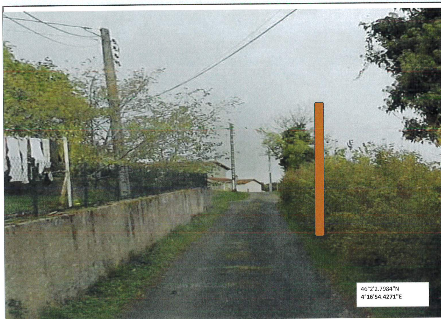
PHOTO DE L'APPUI 2032071 AVANT TRAVAUX
