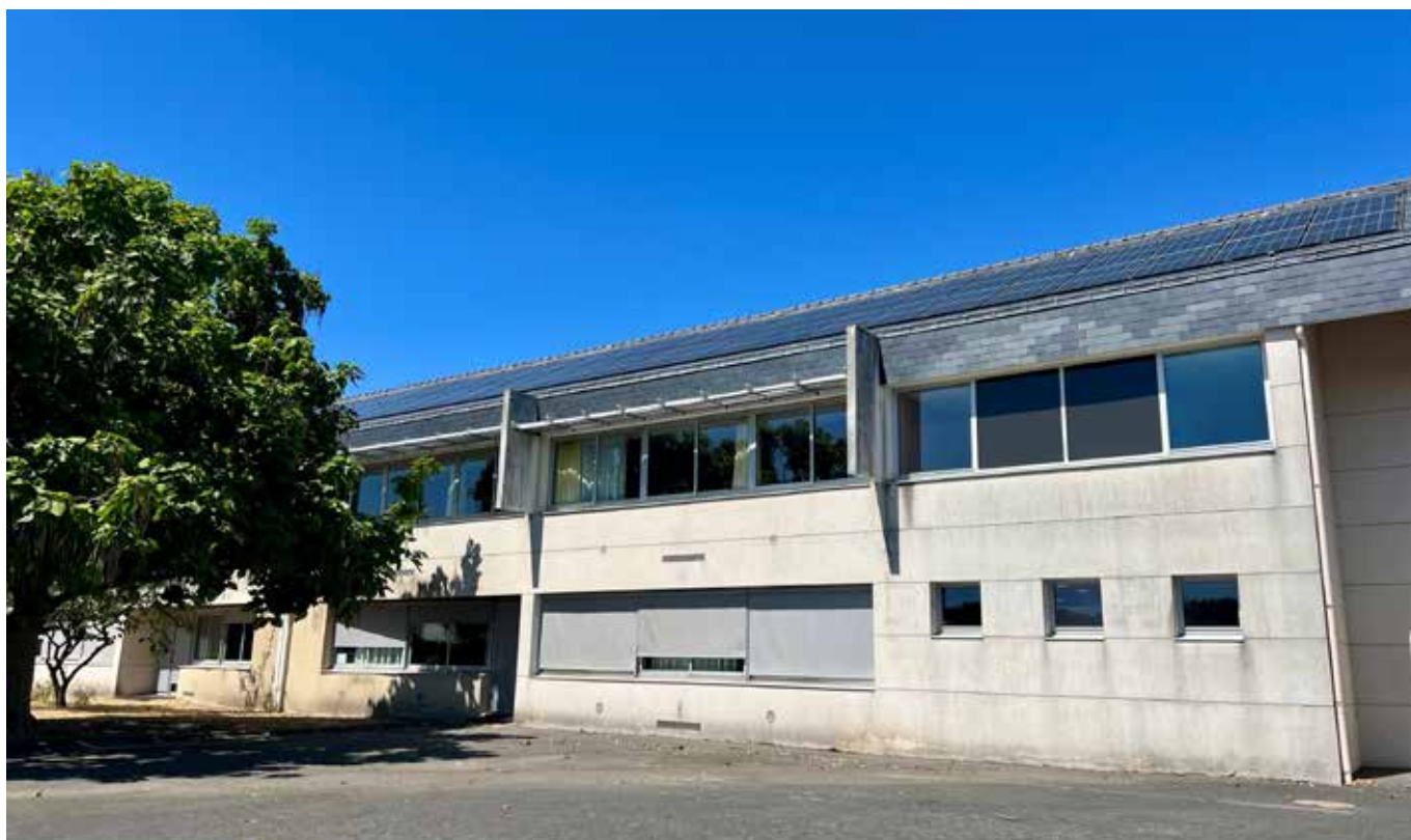
Panneaux solaires sur l'école primaire
