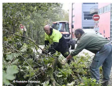
Tempête CIARAN (01/11/2023) Travaux de dégagement de la voirie sur le campus du Terre à Nantes
