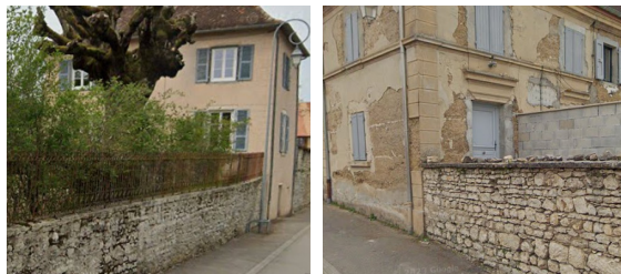
Exemples de murs existants à conserver
