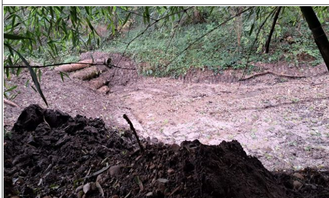
▲ Vue amont du second ouvrage. Comme le bassin amont, la sortie du bassin est fermée par de fortes sections de bois. La buse est installée en position haute.
