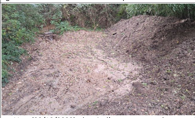
▲ Vue (23/10/2023) depuis l'entonnement du second ouvrage vers l'amont. Une partie des matériaux de curage ont été stockés en rive gauche. Le sommet est plus haut que la levée aval qui ferme l'ouvrage.
