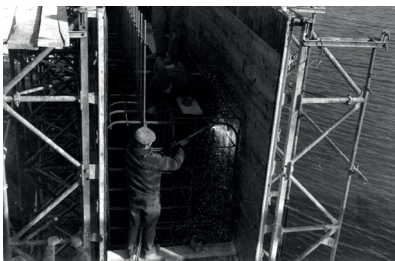
Ferrailage d'une pile
