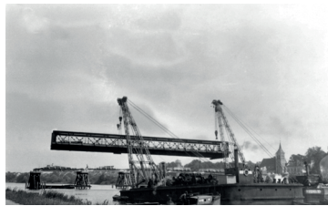
Construction du pont provisoire
