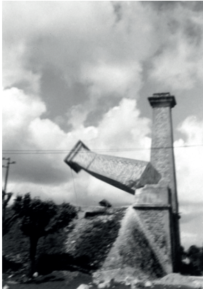
Les restes du pont suspendu en 1941
