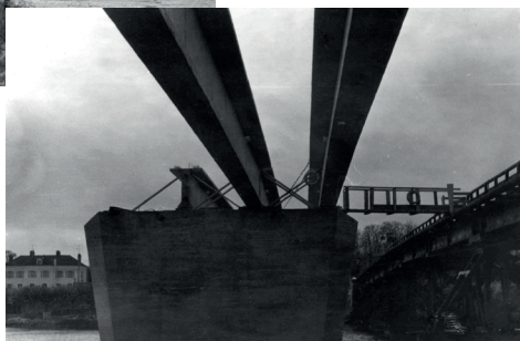
Mise en place des poutres
