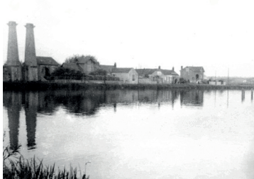
Les restes du pont suspendu en 1941
