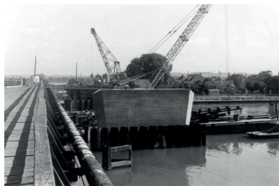
Pile sud terminée
