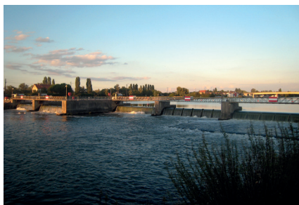
le barrage vu de l'aval
