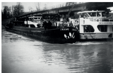
Réparation après une collision avec une péniche
