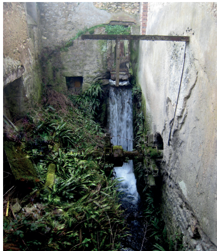
L'axe de la roue à aubes
