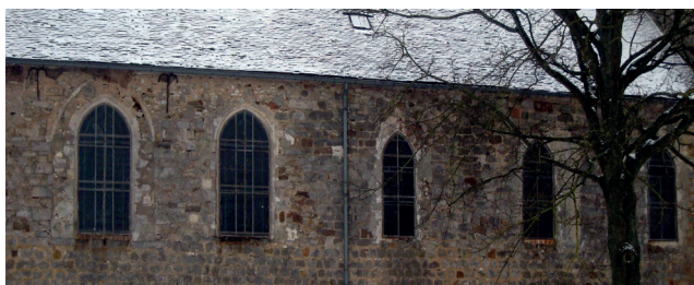
Remaniements des fenêtres côté nord
