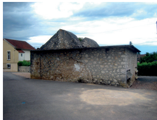
Massif d'ancrage des câbles porteurs du pont suspendu
