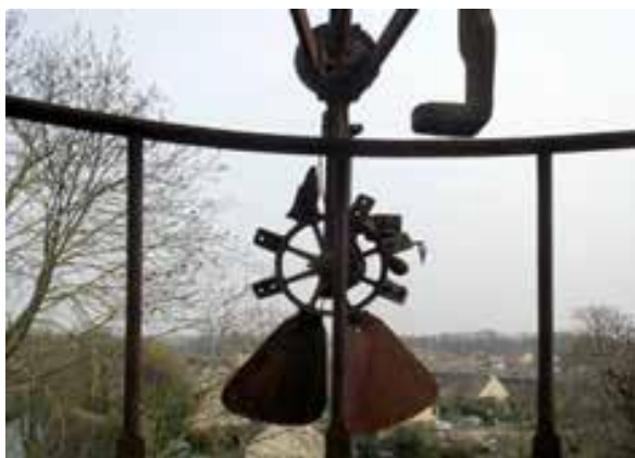
Détail du papillon orientateur (il ne subsiste que deux pales)
