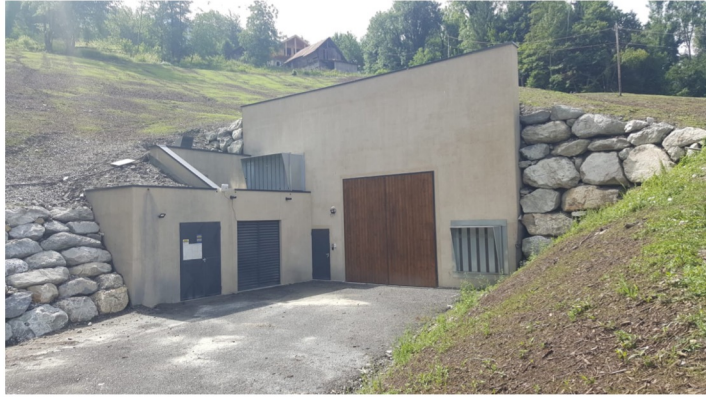
Centrale de ND des Millières semi-enterrée pour annuler l'impact sonore
