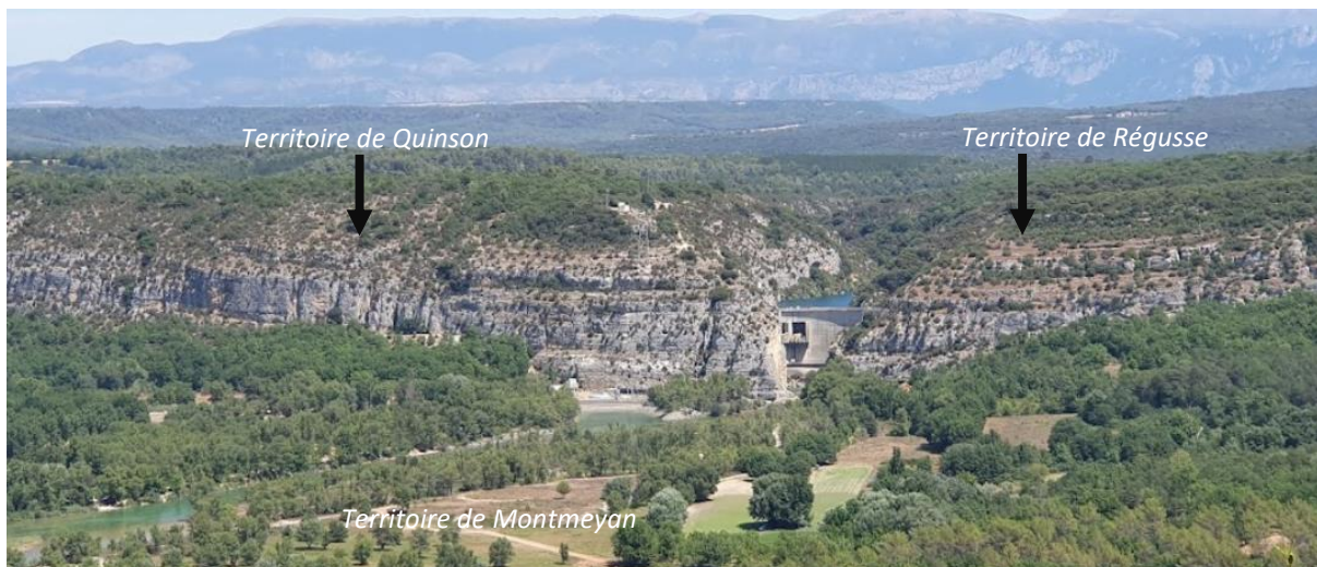
Vue sur le Barrage de Quinson depuis le territoire de Montmeyan
