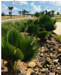
Exemple de noue paysagère à enrochement et plantée ↴
