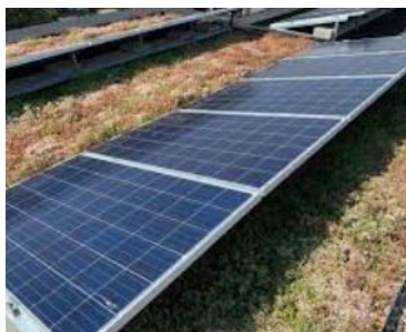
Toiture végétalisée et supportant des panneaux solaires inclinés
