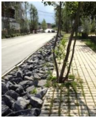
Exemple de noue paysagère à enrochement simple ↴
