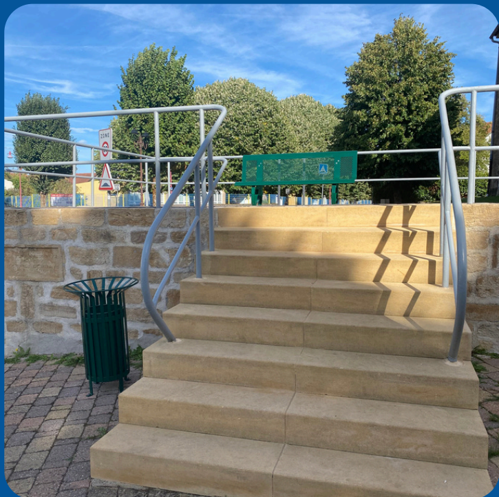
Matériel urbain installé à la Chapelle de Bure
