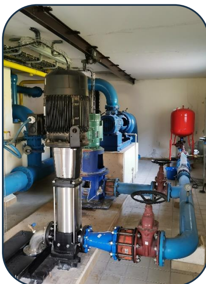
Station du Gué de Leugny
