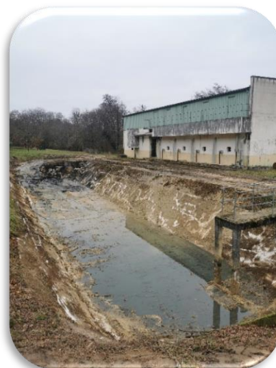
Après le curage de la lagune de DRACY
