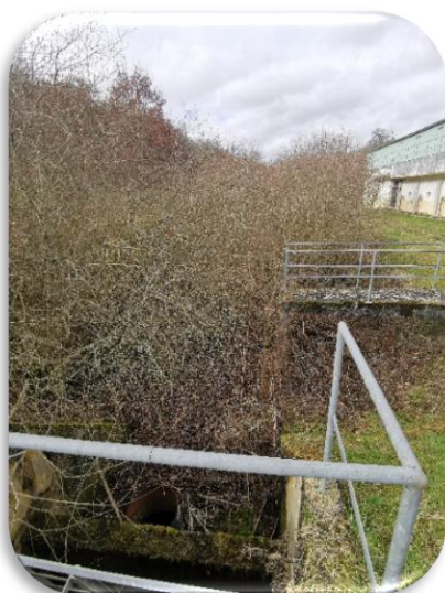
Avant curage de la lagune de DRACY
