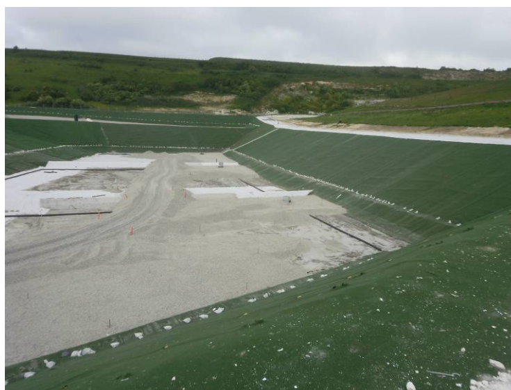
Figure 4 : photo de la mise en œuvre de la barrière active (massif drainant de 50 cm d'épaisseur et drains PEHD)
