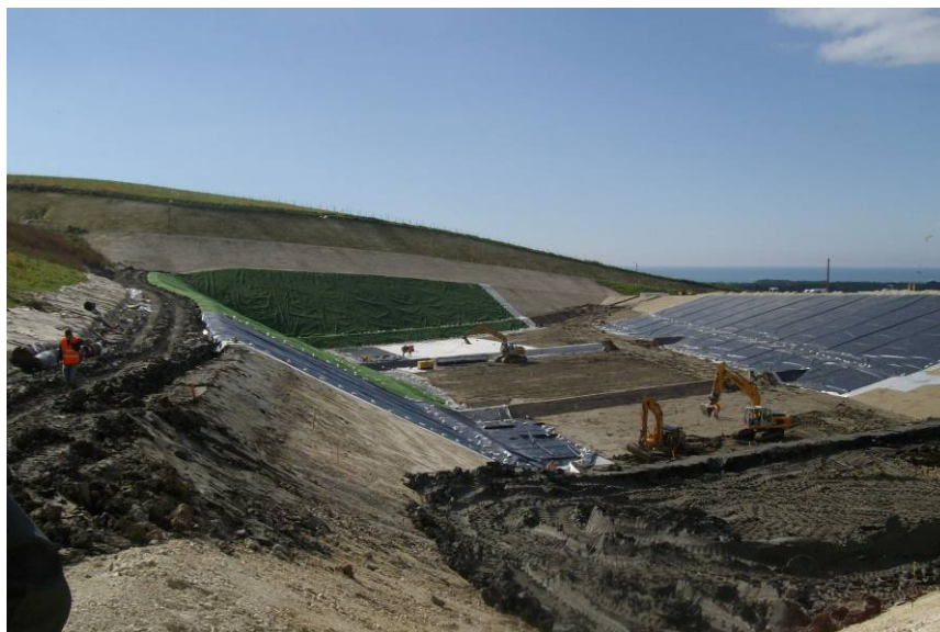
Figure 3 : photo de la mise en œuvre de la barrière active (géosynthétiques)
