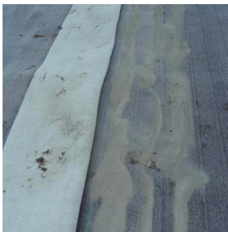
Figure 2 : photo du recouvrement des lès de GSB
