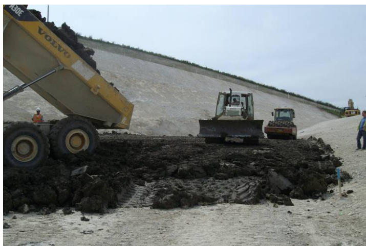
Figure 1 : photo de la réalisation de la planche d'essai
