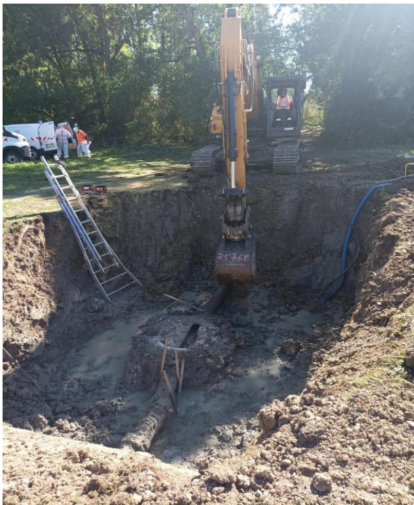
Renouvellement réseau à Reignac-sur-Indre
