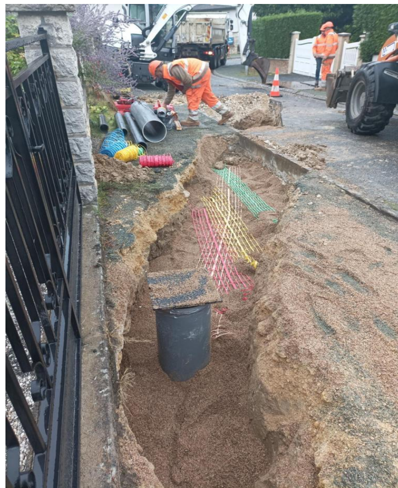
Renouvellement d'un branchement à Loches
