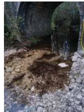
Radier du pont
