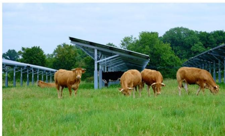
Bovins sous les structures photovoltaïques de l'expérimentation Agro-Ci'nergies.
