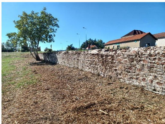
Figure 13 : Mur de soutènement (au-dessus) et buse d'évacuation des eaux de pluie (à droite), (@Réalités Env)
