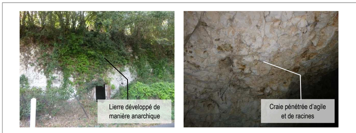
Figure 10 : aperçu du front de coteau et de la cavité souterraine du secteur 2
