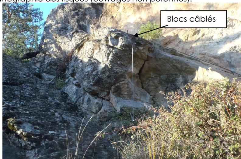
**Figure 11 : Masses stabilisées dans la cicatrice de l'éboulement de 2007**
