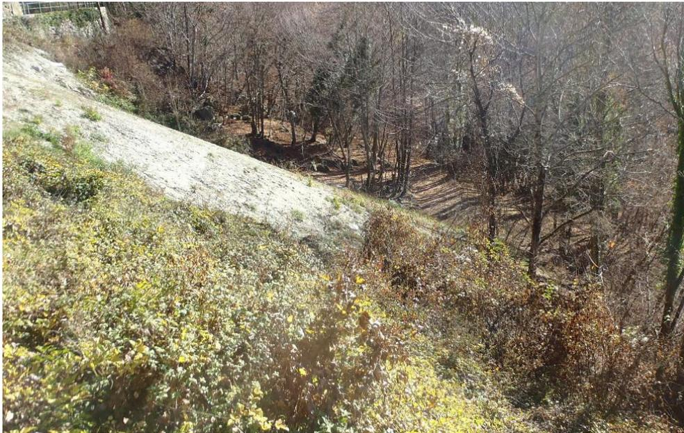
**Figure 17 : Portion de versant talutée après le glissement de 2011**
