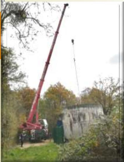
Une **grue de grande taille** est venue pour extraire la **colonne d'environ 34 mètres** de notre puits afin de **remplacer la pompe** défectueuse.
