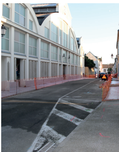
Rue des Cordiers - réfection des trottoirs
