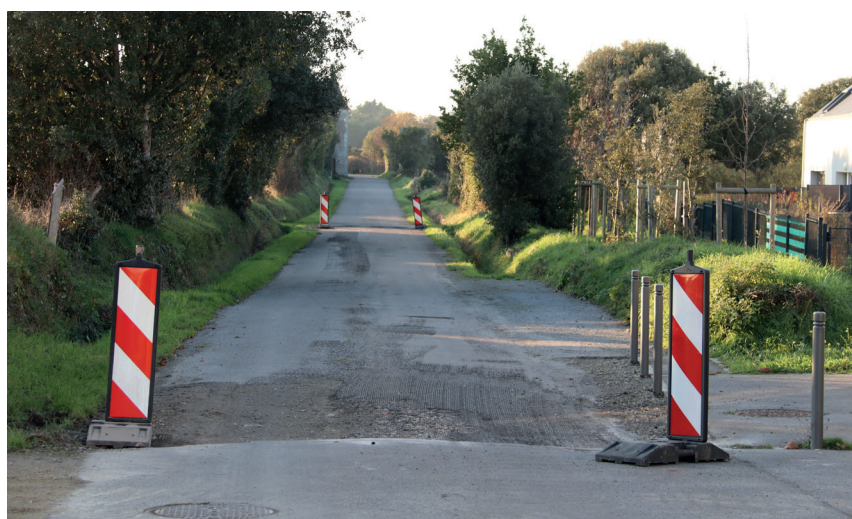
Rue de Kervaudu - reprise des enrobés
