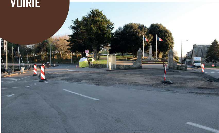
Reprise de chaussée devant l'entrée du Mont-Esprit.
