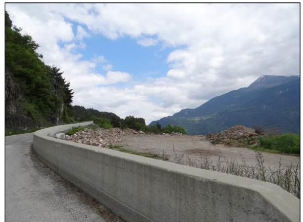
Photo 33 : Zone de stockage de matériaux
