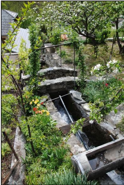
Photo 6 : Canalisation de l'eau à Hautecour la Basse
