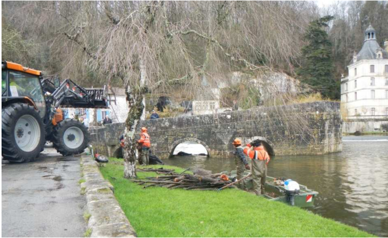
Dégagement du pont coudé lors d'un épisode de crue – printemps 2016.
