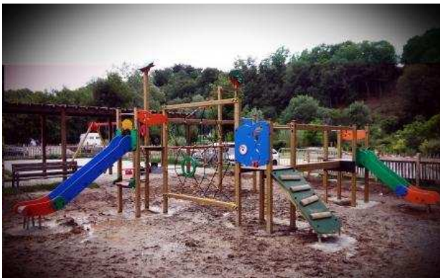
Aire de jeux en chantier.
