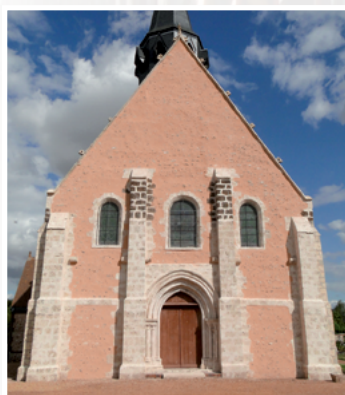
Restauration du pignon ouest de l'église
