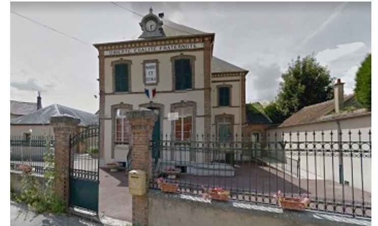
Photo : La Mairie-Ecole d'Aufferville – Sources : Google Street View.
