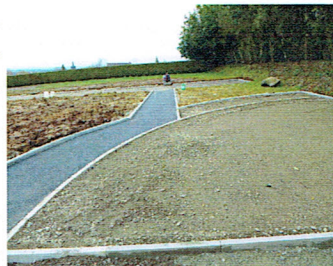
Travaux au cimetière
