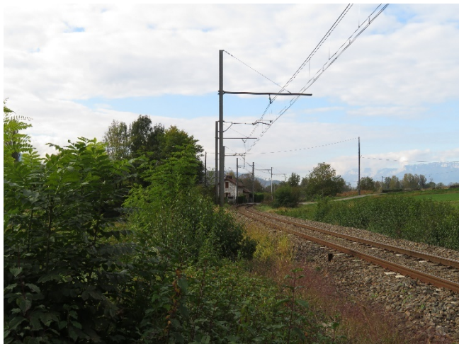
Talus en friche bordant la voie ferrée
