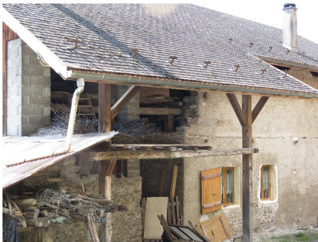
Vieux bâti au lieu-dit « Charrue »
