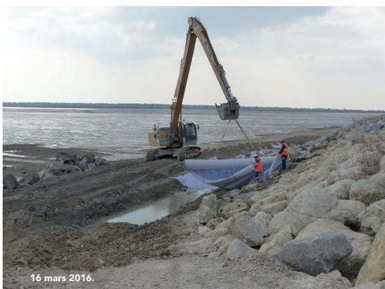
En pied de digue, une bêche est creusée. En langage travaux, c'est le mot pour dire «tranchée». La bêche est profonde pour constituer le lit des fondations.
