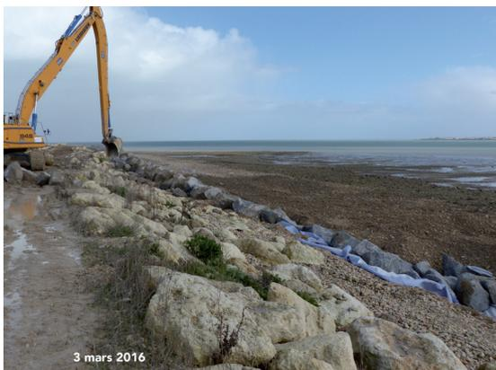
Dès le début des travaux, en dépit des relevés effectués au préalable, le sol meuble a présenté de bien mauvaises surprises. Lorsque les petites pelles de chantier ont été positionnées côté mer., elles se sont enfoncées dans la vase. Finalement il a fallu faire appel à une énorme pelle pour déposer les pierres du mur de consolidation. Munie d'un très long bras, elle a pu intervenir depuis le chemin, là où c'est dur et solide.
