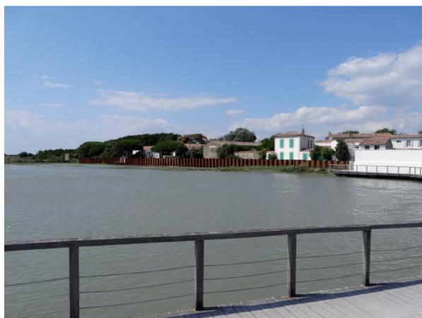
La partie émergée mesure un peu plus d'un mètre. Le pied des palplanches a été végétalisé. En quelques mois, la nature a repris ses droits et elle s'est adaptée.
