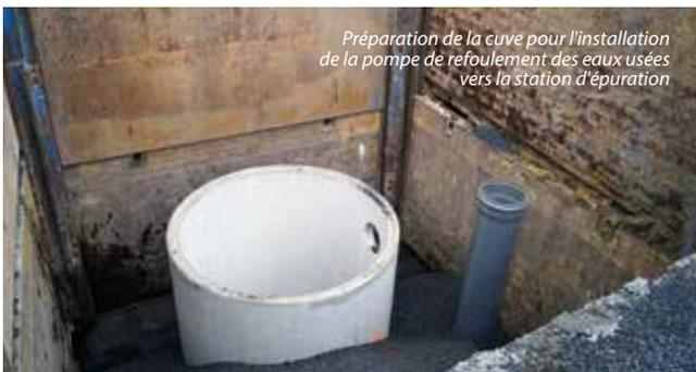
Préparation de la cuve pour l'installation de la pompe de refoulement des eaux usées vers la station d'épuration
