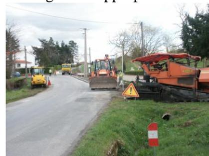
Tout le carrefour a fait l'objet d'un plateau surélevé destiné à freiner les ardeurs des automobilistes. Pour les voitures venant du côté de Bellegarde, un Stop est mis en place au croisement, et la route est rétrécie pour contraindre à un ralentissement de la conduite.
