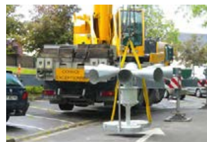
Installation d'une sirène à l'hôtel de ville
