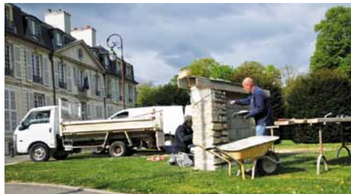
Construction du muret pour mise en place du blason de la ville.
