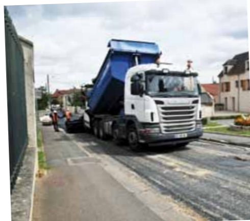
Enrobage du tablier route du Lavoir, le 31 juillet 2017.
