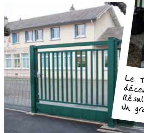
Un nouveau portillon installé et un accueil sécurisé devant l'école élémentaire.
