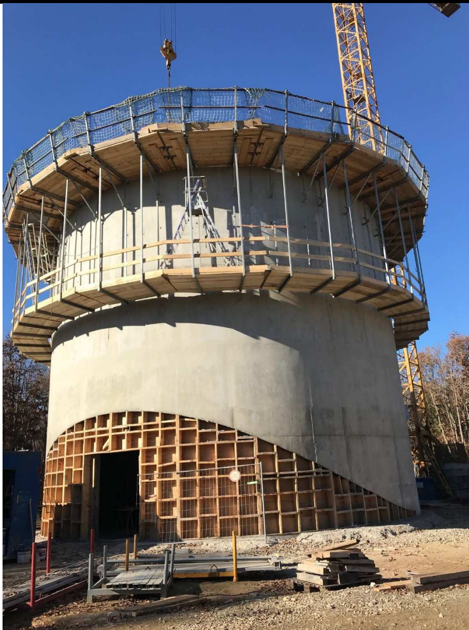
Décembre 2017 - construction château d'eau de Bérat - 1500 m 3
