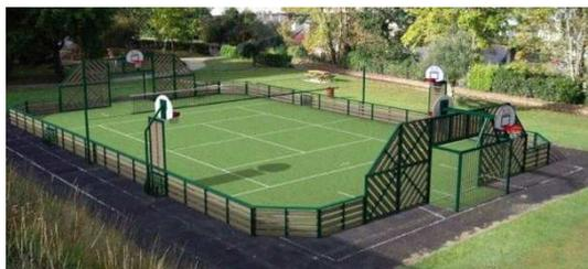
Ce terrain multisports permettra de jouer au foot, au handball, au basket, au volley-ball, au hockey, au badminton et au tennis. Son revêtement est constitué d'un gazon synthétique de 25 mm et d'une couche de sable de 20 mm. Sa structure en métal anticorrosion et bois autoclave (sans entretien) s'intégrera ainsi parfaitement au paysage.
