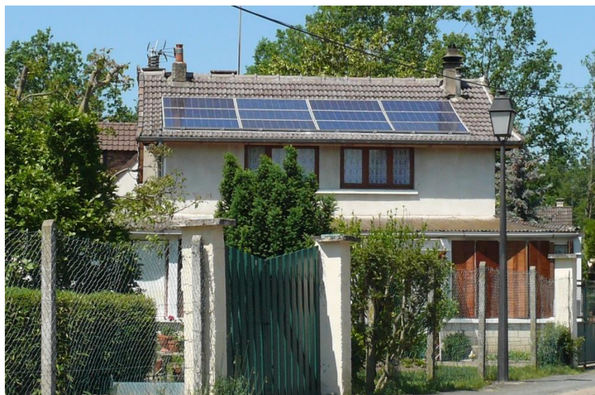
FIGURE 23 : UNE MAISON EQUIPEE DE PANNEAUX PHOTOVOLTAÏQUES A CERNY (Photo TRANS-FAIRE)
