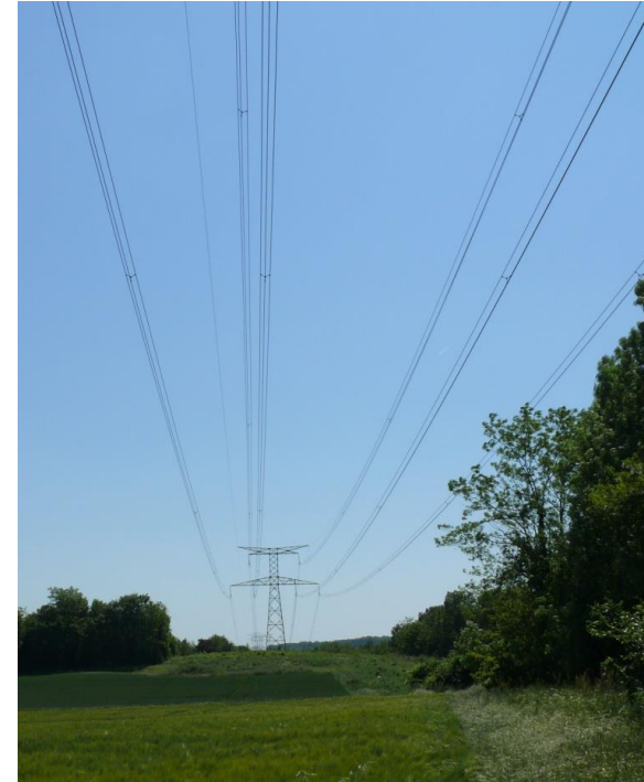
FIGURE 40 : PASSAGE DE LA LIGNE ELECTRIQUE A HAUTE TENSION AU NIVEAU DE « LA PETITE MONTAGNE » A CERNY (photo TRANS-FAIRE)
