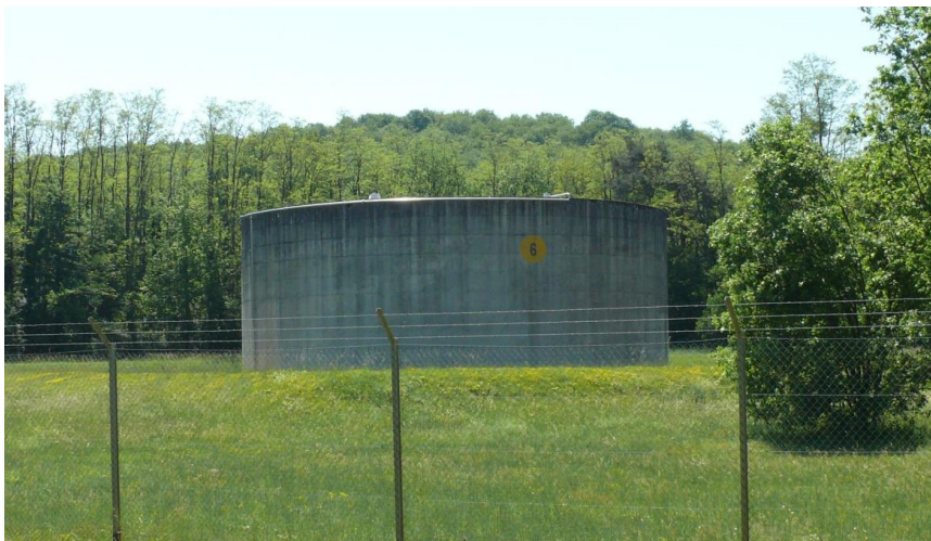
FIGURE 34 : L'UN DES RESERVOIRS DE STOCKAGE D'HYDROCARBURES DE LA SFDM A CERNY (photo TRANS-FAIRE)
