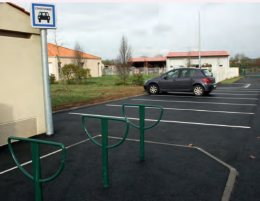
Le parking de covoiturage est en service depuis début 2017.
