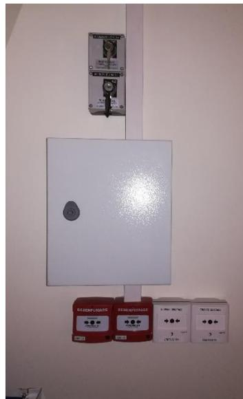
Lorsqu'un incendie est détecté, il faut ouvrir les baies de désenfumage du plafond. Pour cela, appuyer sur les 2 déclencheurs rouges situés dans le sas d'entrée : 1 pour les baies 1 et 2, côté fond de la salle – 1 pour les baies 3 et 4, côté scène. Les baies s'ouvrent complètement automatiquement.
