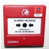
Celle-ci se déclenche à partir d'un appui sur un des 5 déclencheurs répartis dans la salle, près des portes de sortie.
