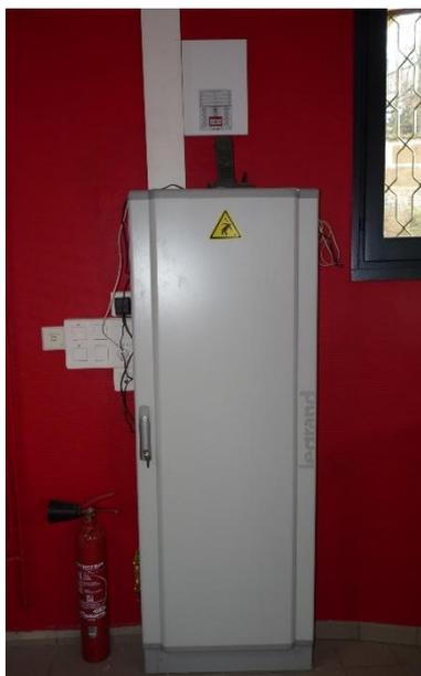
L'armoire principale d'alimentation de la salle des fêtes se trouve derrière le bar. La clef de cette armoire se trouve dans un coffret à clefs derrière le bar près de l'armoire électrique.
