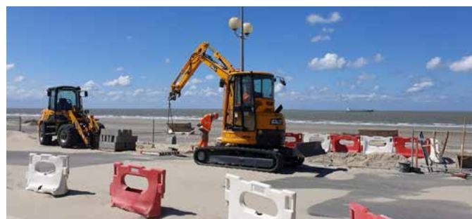
Relance du chantier de la digue pour dynamiser l'économie locale
